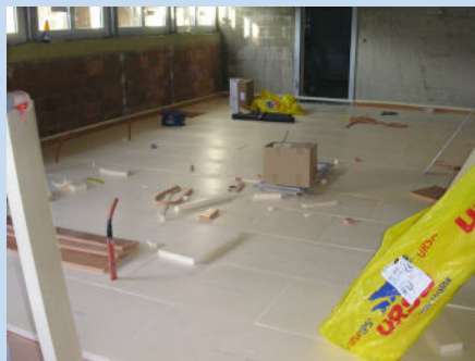
Lagerung mit Durchdringungen und Wärmedämmung
