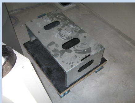
Trägerkonsole der Lüftungsanlage mit eingebautem Stahl Druckfeder-System ISOLASTIC
