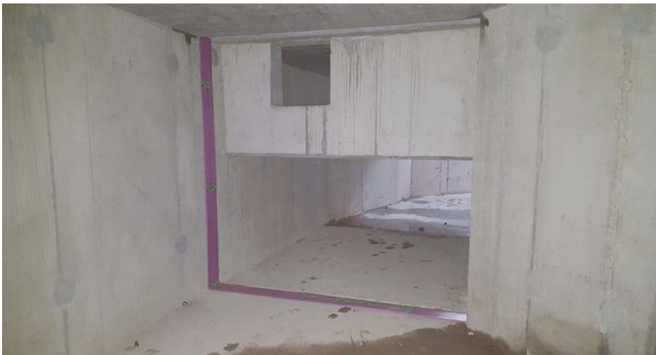
Abb. 13: Abdichtung des Unterwasserkanales
