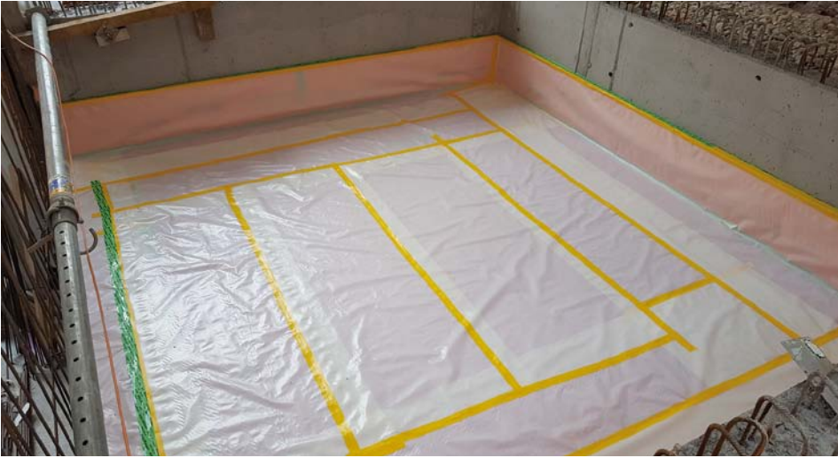
Abb. 10: Lagerebene Generator-Fundament, abgedeckt mit zwei Lagen PE-Folie
