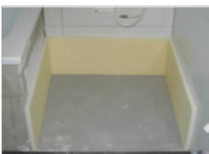
Anbringen der Randstellstreifen ISOPE
