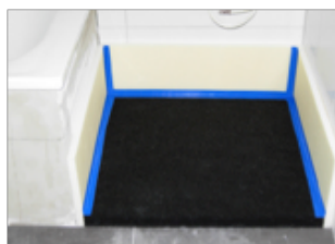
Verlegen der Schalldämmlager ISOPOL® oder ISOLMER®
