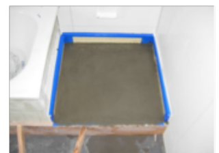
Einbringen des Massefundaments
