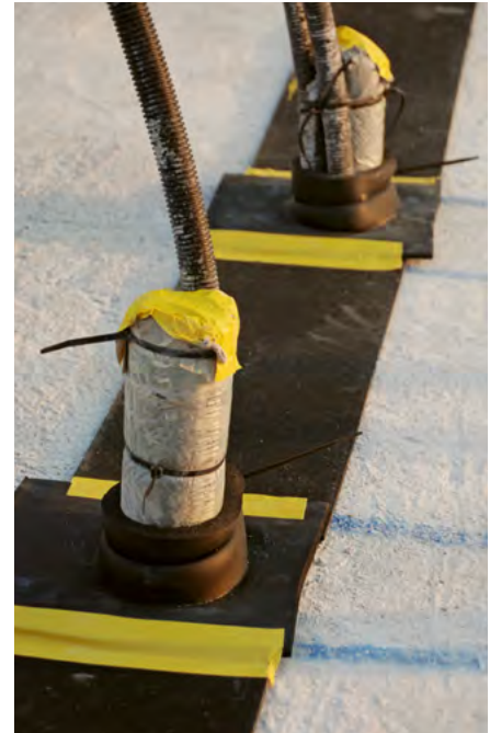
Passages de tuyaux dans la zone des ISONOVA® appuis de séparation acoustique avec ISOLINE-SPEEDY
