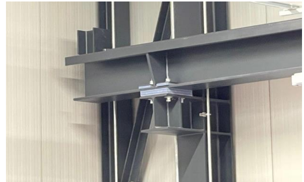
Exemple d'un appui en PUR de type ISOCRANE-M
