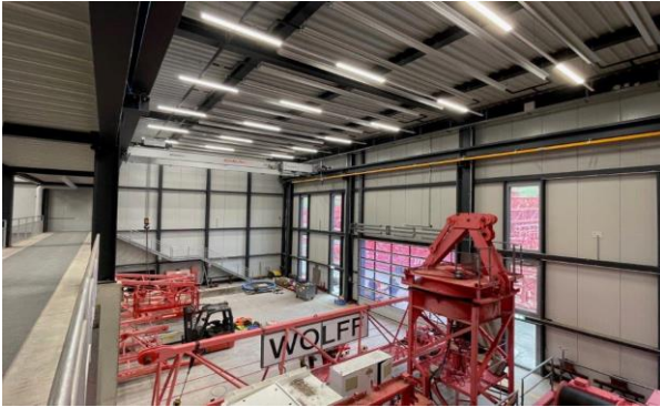
Vue d'une partie du nouvel atelier
