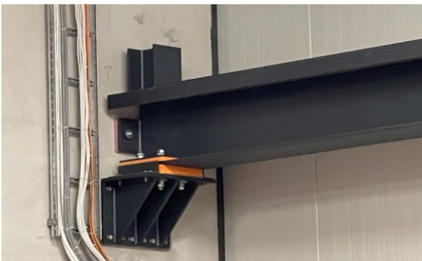
Exemple de raccordement à la paroi en béton des bureaux avec le système d'appui en PUR de type ISOCRANE-L. ISOCRANE-L fournit une très bonne isolation des bruits solidiens, même sans charges, et convient parfaitement à cette zone sensible
