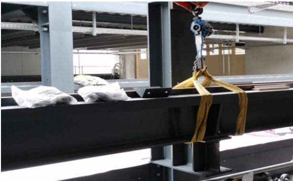
Lors de la mise en place des appuis et des voies de roulement, surtout afin d'éviter les ponts phoniques, l'entreprise de construction métalliques a bénéficié des conseils professionnels d'un spécialiste de HBT-ISOL
